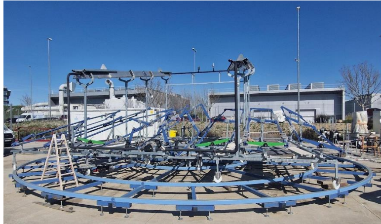
Fig. 1. Construcción de SunDial para MAN.
